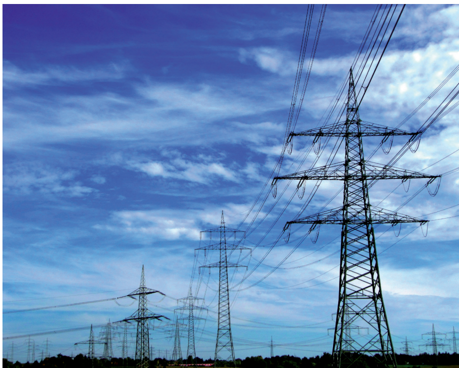
Anbindung der Offshore-Energie an das Stromnetz als große Herausforderung
